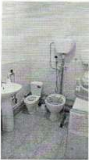
Фото №13 – санитарно-гигиеническое помещение
