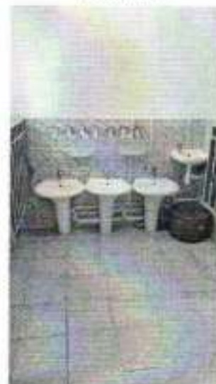
Фото №12 – санитарно-гигиеническое помещение
